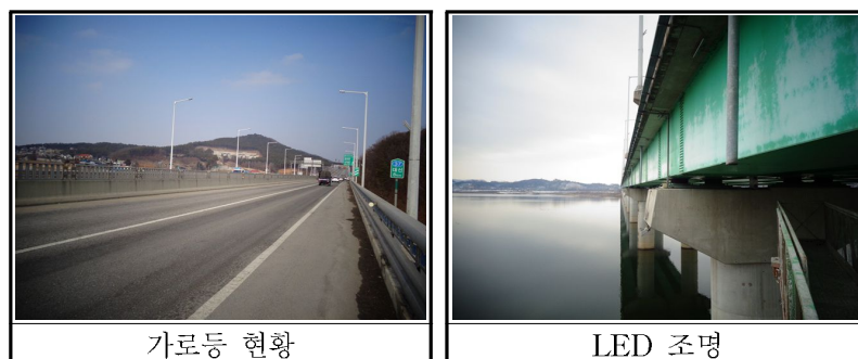
【그림 3.21】 부대시설 설치현황
