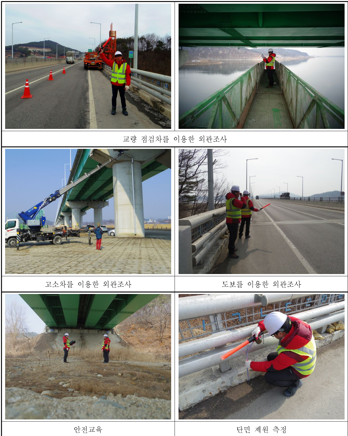
【그림 3.2】 외관조사 전경
