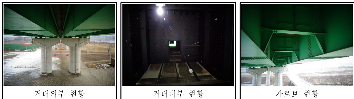
【그림 3.9】 Steel Box Girder 현황
